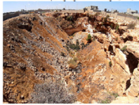
صورة (14) دولابن في منطقة بوعطني ، لاحظ عمليات الردم بالنفايات الصلبة
