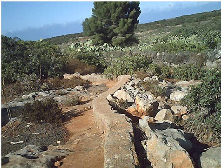
صورة رقم 5 حفر لخرن المياه . وقناة مرممة لنقل المياه ( الصورة السفلية ) تصوير الباحثة
